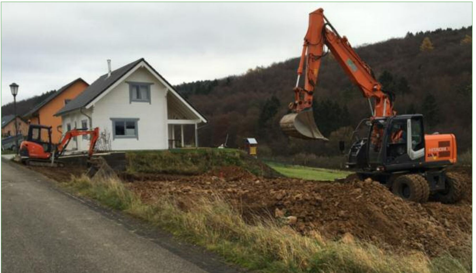
Ein Spezialgebiet von Lohnunternehmen Krämer sind Hausausschachtungen und alle damit verbundenen Arbeiten
